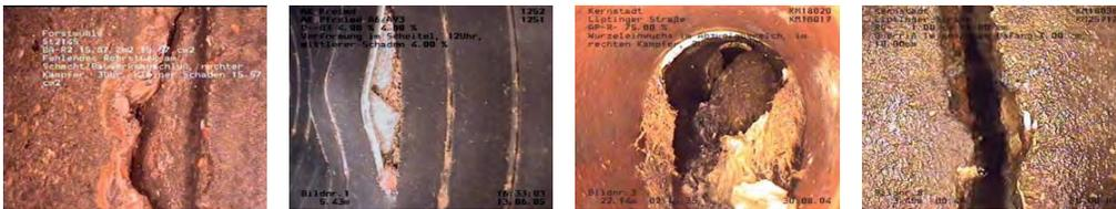
**Mit dem TbL-Verfahren werden schadhafte Abwasserleitungen (DN 100 - 400 mm) repariert und somit dauerhaft abgedichtet und saniert.**
